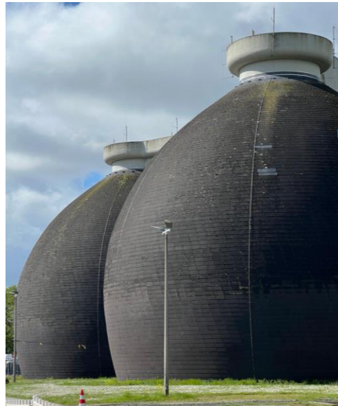
м.Мюнстер (метантенки з утилізації мулу)
